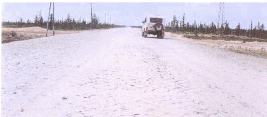
Геоячейки «ПРУДОН-494» в основании автодороги
